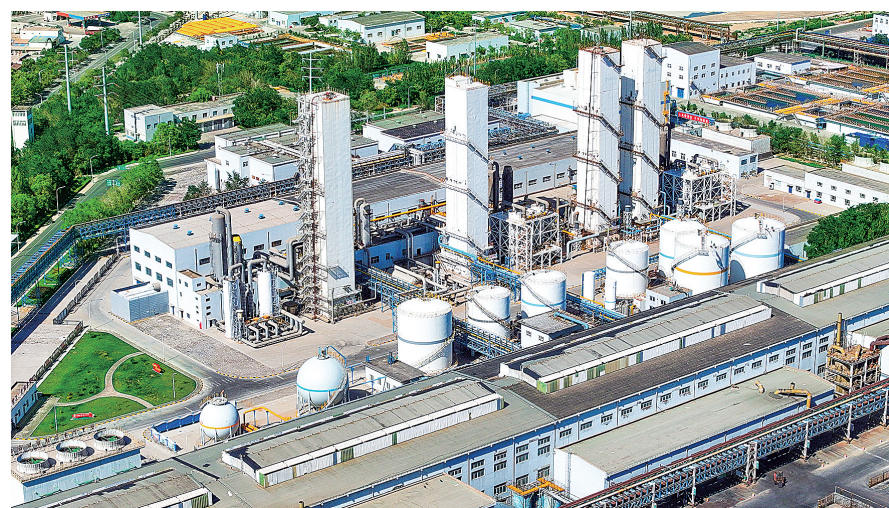
金川镍钴动力厂动气车间,是目前河西片区最大的空分制氧集群。
