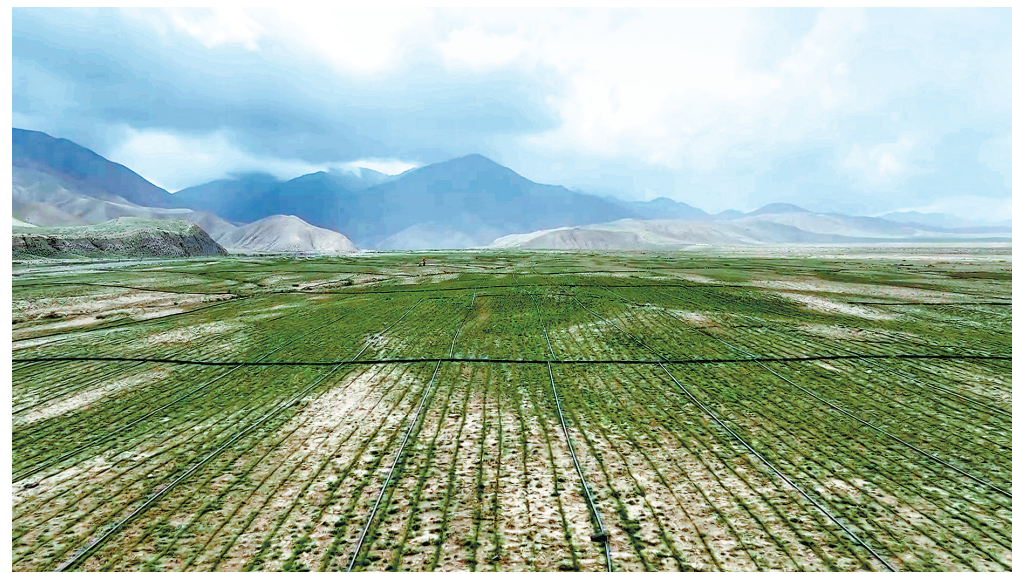
酒泉祁连山北麓水源涵养与生态保护修复项目施工现场。
