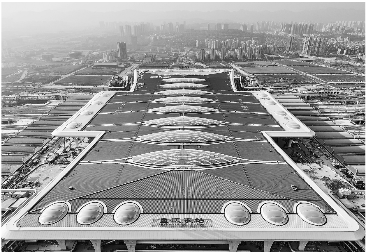
这是12月23日拍摄的正在建设中的重庆东车站房及配套综合交通枢纽工程。目前,工程正加紧建设,进展顺利,建成后 will 引入渝湘高铁、渝万高铁、渝贵高铁、渝昆高铁等多条线路,成为西部地区最大高铁枢纽站。重庆东站预计将于2025年与渝湘高铁重庆至黔江段同步建成投用。 新华社发
