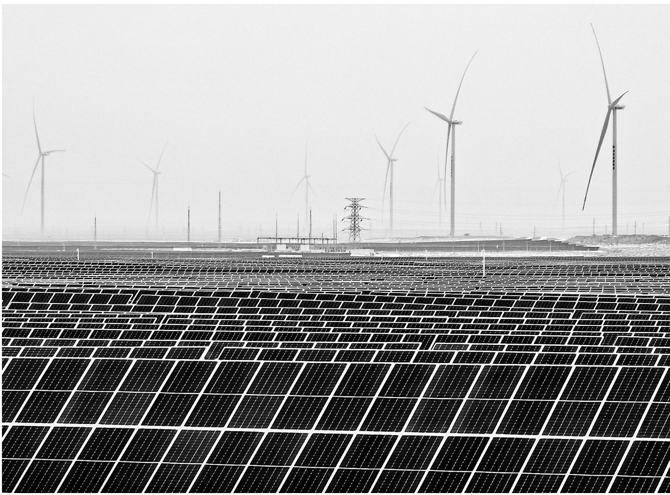
隆冬时节，临泽县北部滩新能源产业园内，蔚为壮观的81.1万千瓦光伏集阵和85万千瓦风力发电机组群，将光热和风力转换为电能。
