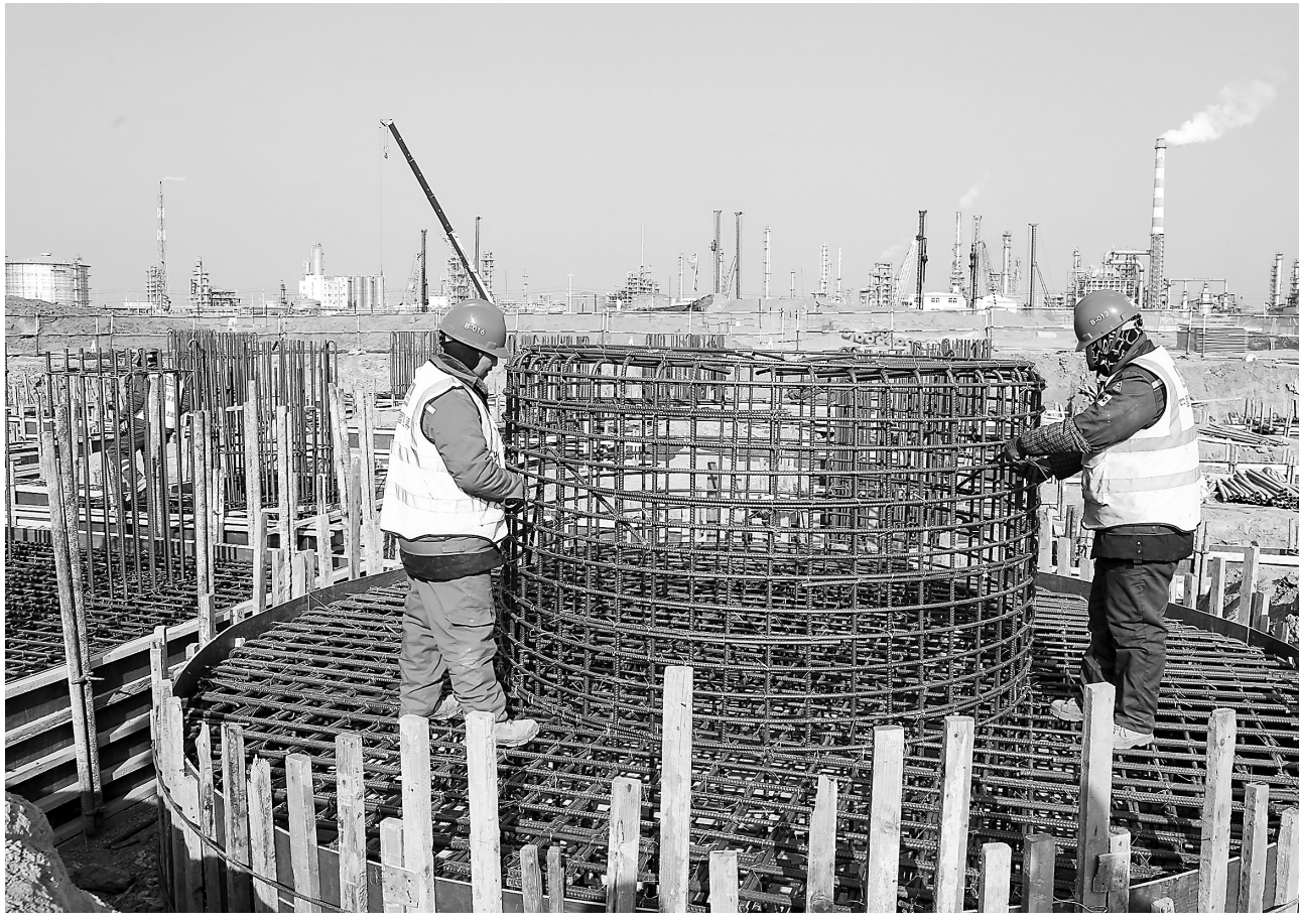
近日,在庆阳同欣50万吨/年轻烃深加工项目建设现场,工人正在加紧施工。
