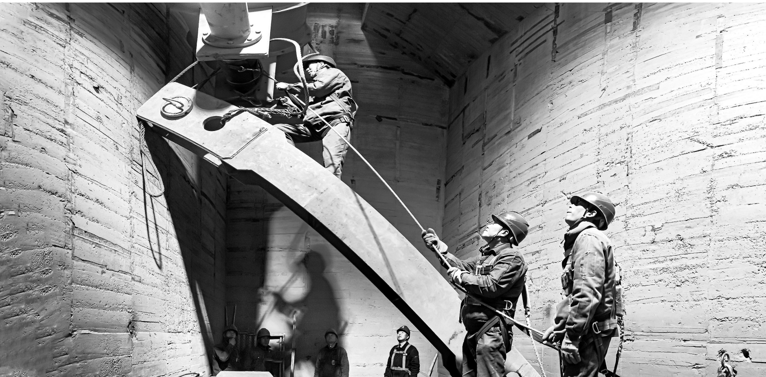
近日,国网甘肃刘家峡水电厂工作人员利用枯水期开展排沙洞事故检修闸门维修,确保闸门在汛期能够正常运行。
