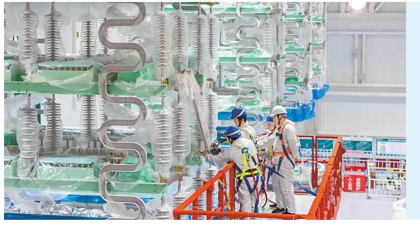
日,在"疆电入 渝"特高压渝 北 ± 800 千 伏 换流站工程施 工现场,技术 人员在进行国 产换流阀的安 装作业。渝 北 ± 800 千 伏 换流站是西南 地区首座受端 换流站,计划 2025年6月份 实现双极低端 投运
