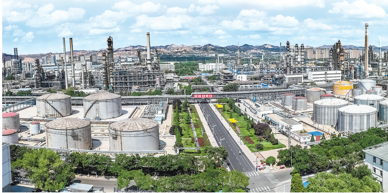
兰州西固化工园区全面完成省级二级化工园区认定。
