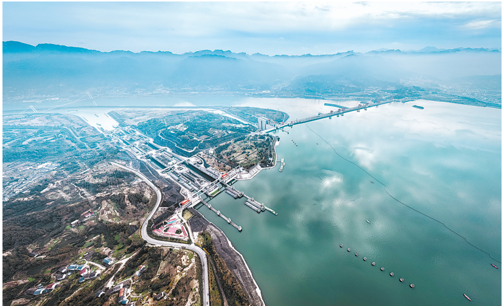
2023年12月1日,船舶有序通过三峡双线五级船闸(无人机照片)。2024年12月14日,三峡工程迎来开工建设30周年。 新华社发
