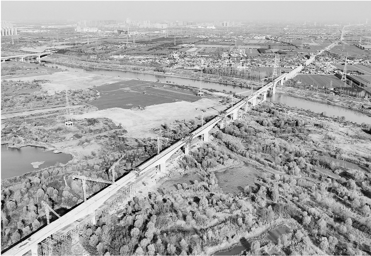
12月13日,由中铁二十局承建的西(安)延(安)高铁渭河特大桥连续梁全部合龙,为确保项目如期建设奠定坚实基础。渭河特大桥主桥长约1644米,是全线重难点控制性工程之一。
