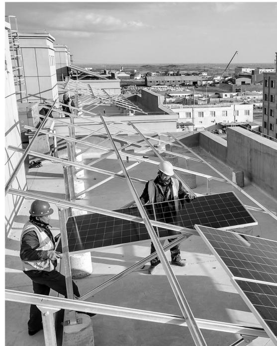
近日,在金塔县北河湾工业园区的屋顶分布式光伏发电项目建设现场,工人们正在安装光伏板。金塔县整县推进分布式光伏发电项目,充分利用公共建筑、学校教学楼等闲置屋顶安装分布式光伏装备,着力构建以新能源为主体的新型电力系统。新甘肃·甘肃日报通讯员 曹红祖
