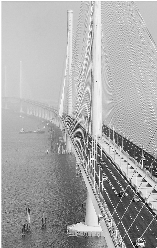
12月11日,国家重大工程黄茅海跨海通道正式通车。黄茅海跨海通道是《粤港澳大湾区发展规划纲要》发布后首个开工的跨海通道工程,也是继港珠澳大桥、深中通道之后大湾区又一跨海通道重大工程。 新华社记者 刘大伟
