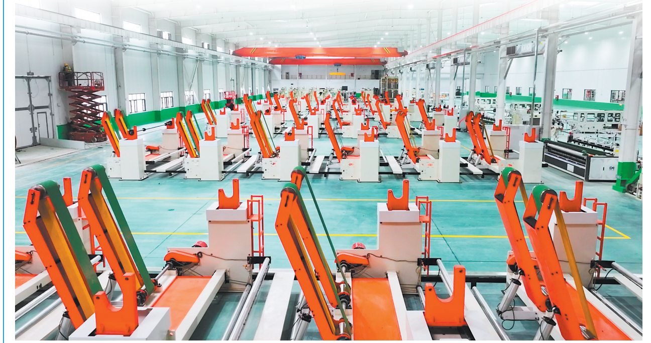
崇信县甘肃雨森年产36万吨生活用纸项目建成后,将成为西北地区规模最大的造纸基地。新甘肃·甘肃日报通讯员 徐炜场
