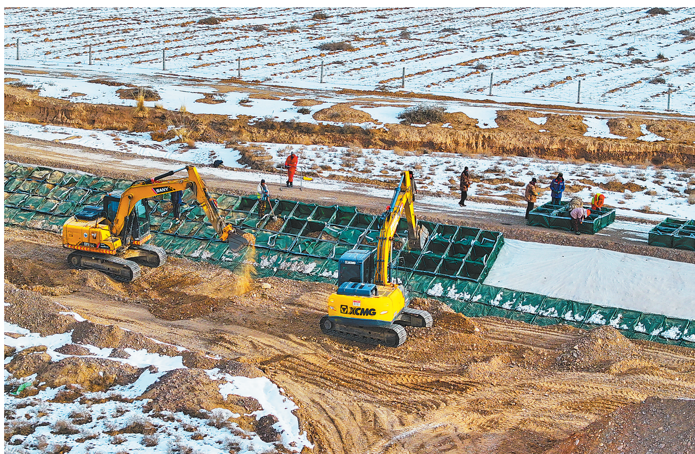
近日,在民乐县童子坝河民联至六坝段河道治理工程施工现场,工人正在修筑河堤。工程完工后,将有效改善受益区群众的生
