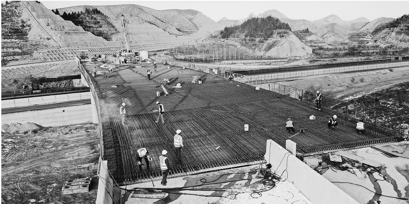
近日,G1816乌海至玛沁高速公路兰州新区至兰州段(中通道)项目现场,工人们全力冲刺工期的最后关键节点,确保按时完成通车目标。
