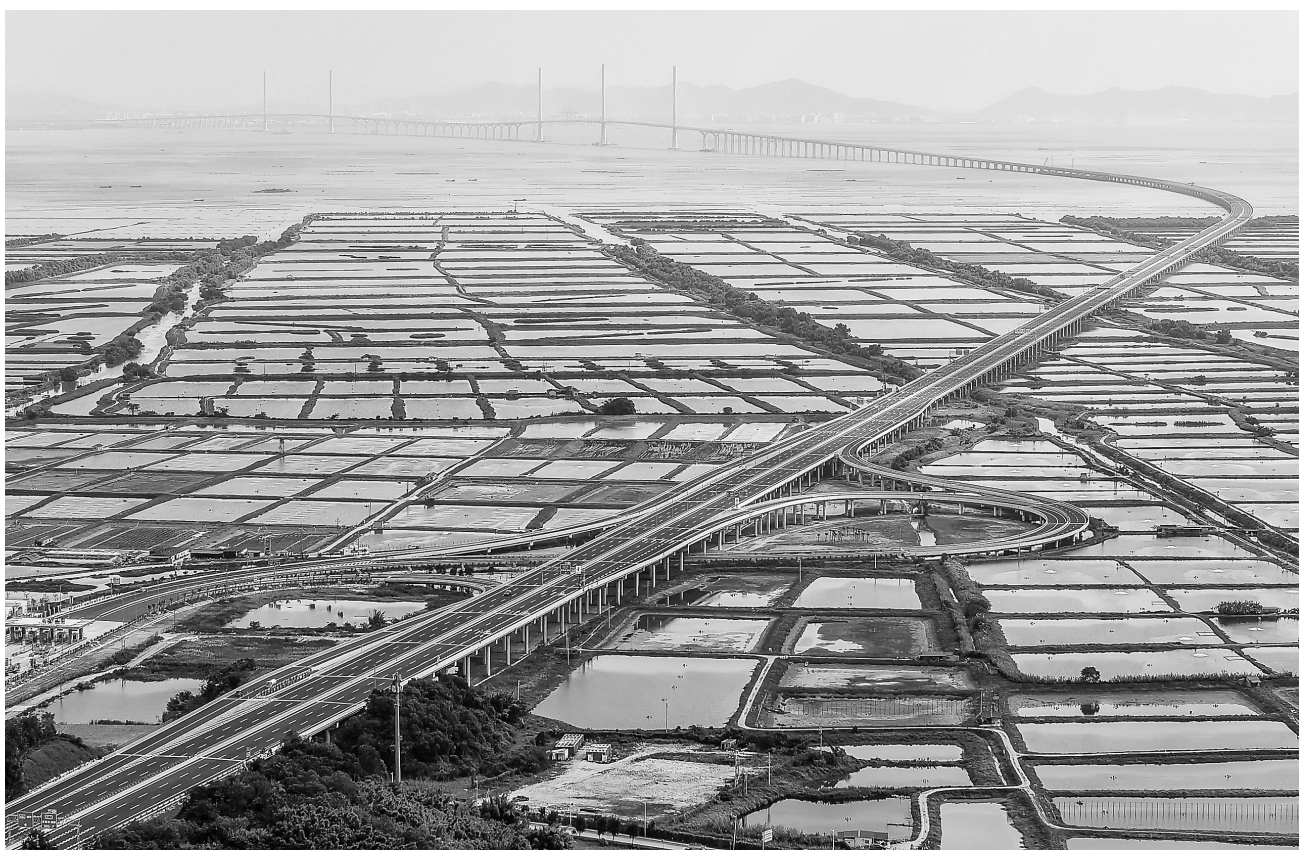
黄茅海跨海通道经黄茅海大桥登陆广东省江门市台山赤溪镇,这是12月4日拍摄的赤溪东互通立交。日前,由中铁十一局承建的黄茅海跨海通道台山段已全部建设完毕,静待通车。新华社记者 刘大伟
