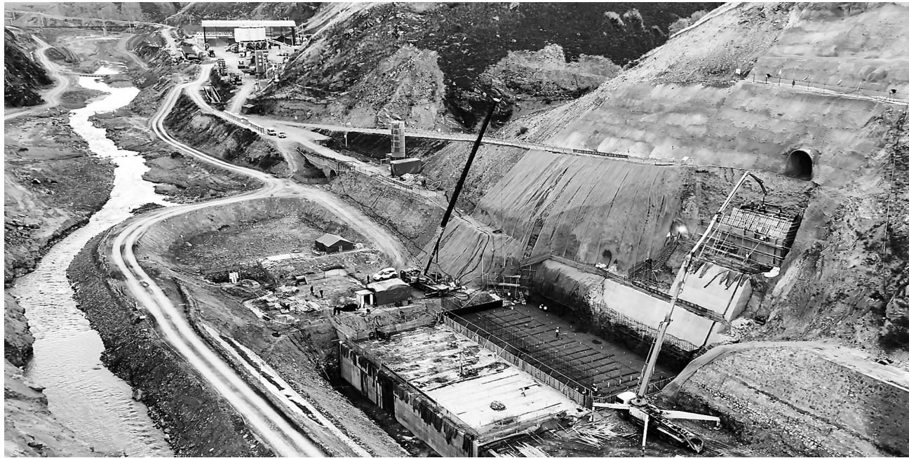
近日,庄浪县阳川上峡口水库工程建设现场,泄洪闸基础和水库右岸重力坝混凝土浇筑工作正在有序推进。该工程是全国抗旱规划和全省“十四五”水利发展规划实施的重点水利项目之一。
