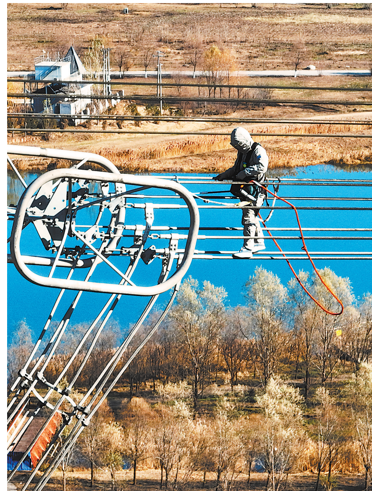
近日, 河北雄安新区首次开展直升机规模化带电检修作业, 带电作业人员走线至 1000 千伏定河线作业位置准备开展工作。新华社发
