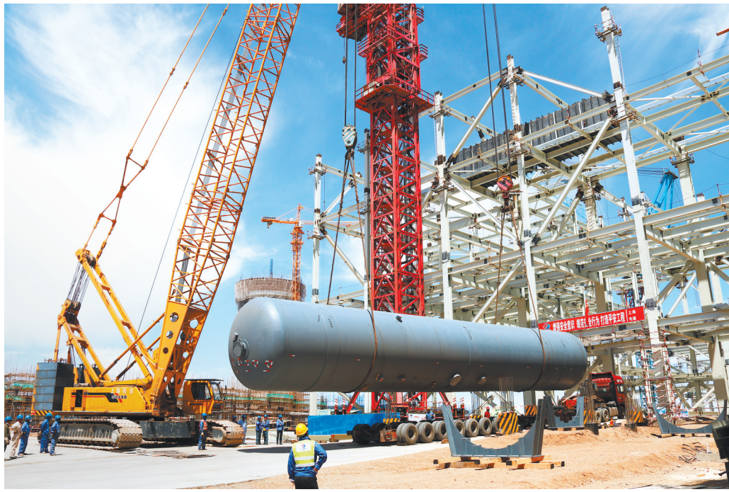
2018年7月12日,甘肃电投常乐电厂1号机除氧器吊装现场。(资料图)
