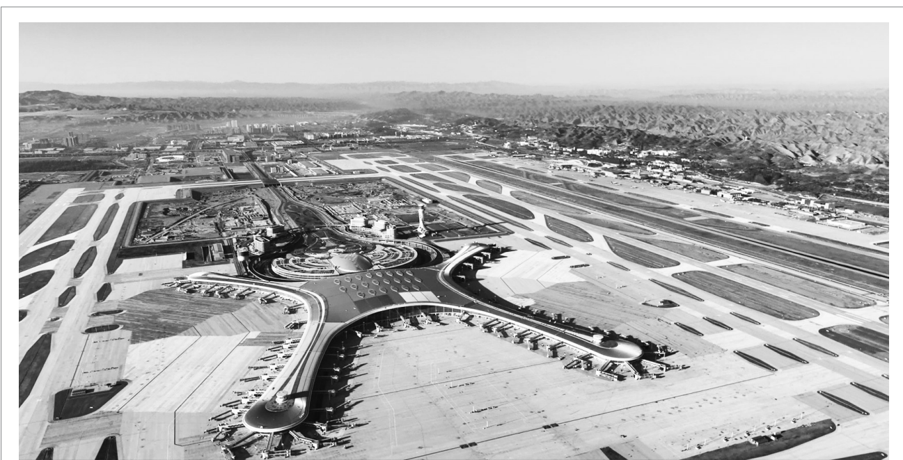
近日,兰州中川国际机场三期扩建工程飞行区工程通过竣工验收,标志着该项工程向实现转场投运目标又迈进了一大步。兰州中川国际机场三期扩建工程飞行区工程于2020年10月16日开工建设。四年来,百余家参建单位、万余人共同奋战,全面推进工程建设。据了解,此次飞行区工程顺利通过竣工验收后,兰州中川国际机场三期扩建工程将开展试飞和行业验收等工作。
