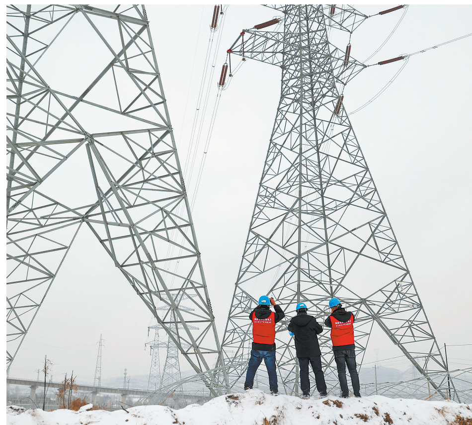
11月24日,国网平凉供电公司输电运检中心巡线人员在平凉峡门乡山口子村110千伏西米线开展覆冰巡视,确保迎峰度冬期间电网正常运行。
