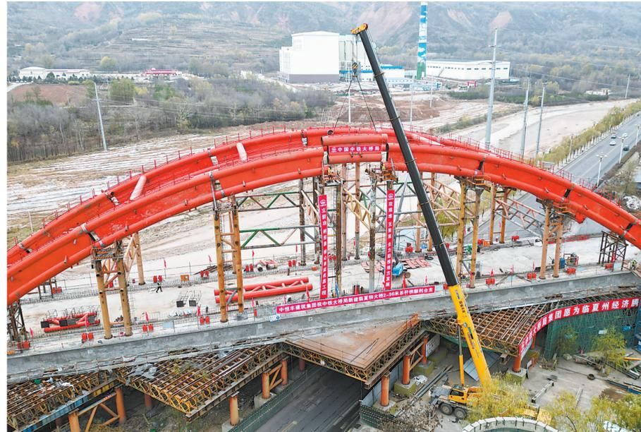
11月16日,中铁大桥局承建的兰州至合作铁路站前工程临夏特大桥2-9米系杆拱桥第二孔钢管拱顺利合龙,为主桥建成奠定了坚实的基础。新甘肃·甘肃日报通讯员 史有东
