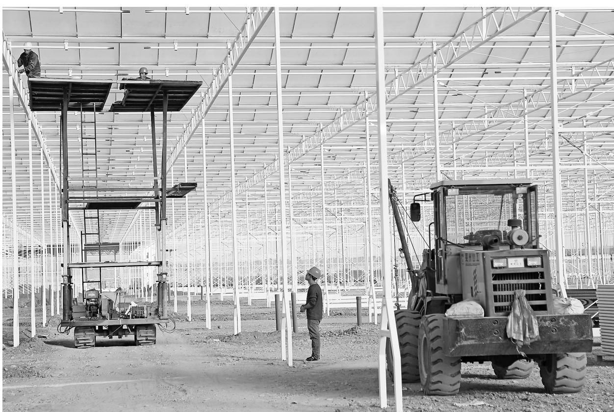
近日,在民乐县现代高科技智能化设施温室项目建设现场,工人正在进行顶棚及管网安装作业。
