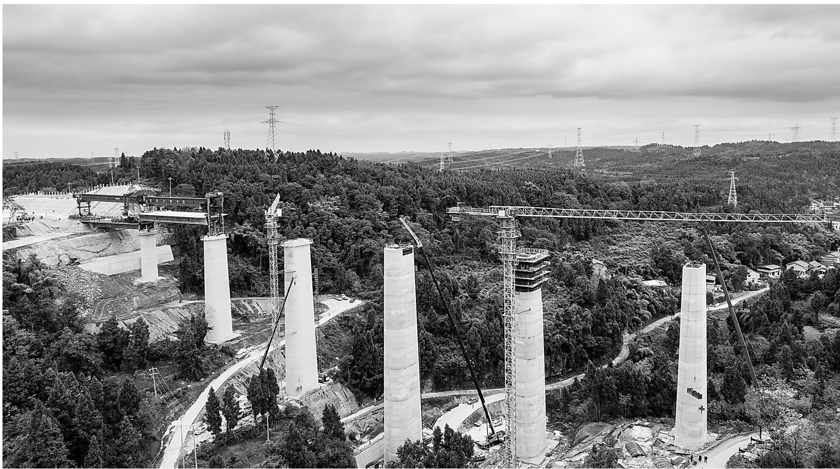
十一月十七日,中铁五局成渝中线高铁四川段项目部的架桥机将箱梁架设在成渝中线高铁麻湾特大桥桥墩上。当日,成渝中线高铁首个千吨箱梁完成架梁,为高速铁路平稳运行和进一步提速创造了条件。 新华社发
