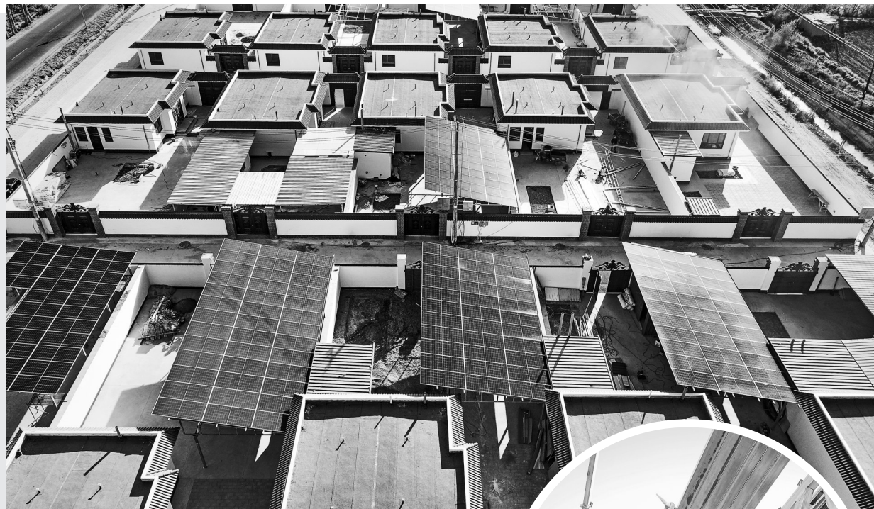
11月11日，高台县合黎镇五三村生态及地质灾害避险搬迁安置点，工人正在组装光伏电板。
