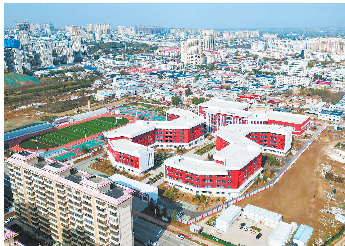
初冬时节，庆阳市西峰区学院路实验学校项目正在加紧建设。
