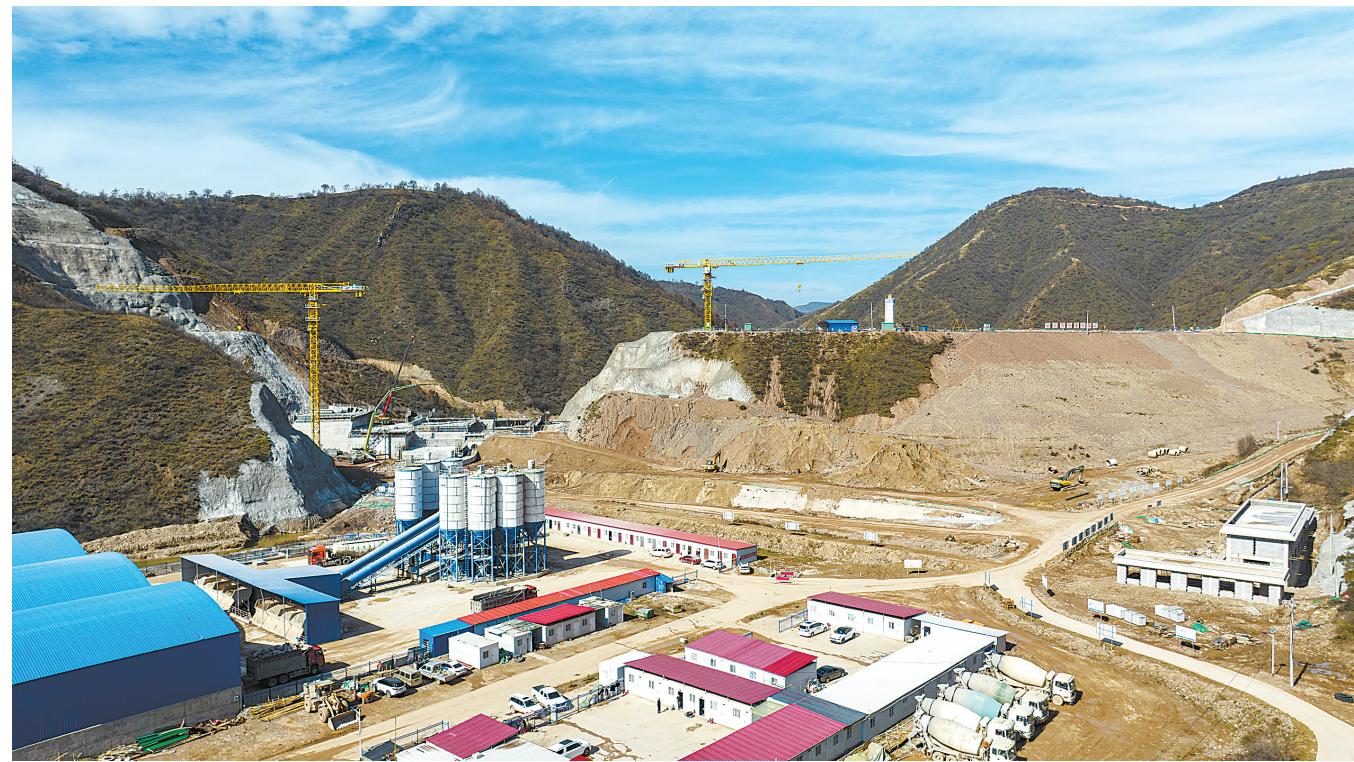
近日,平凉市崆峒区麻武水库在加紧施工。
