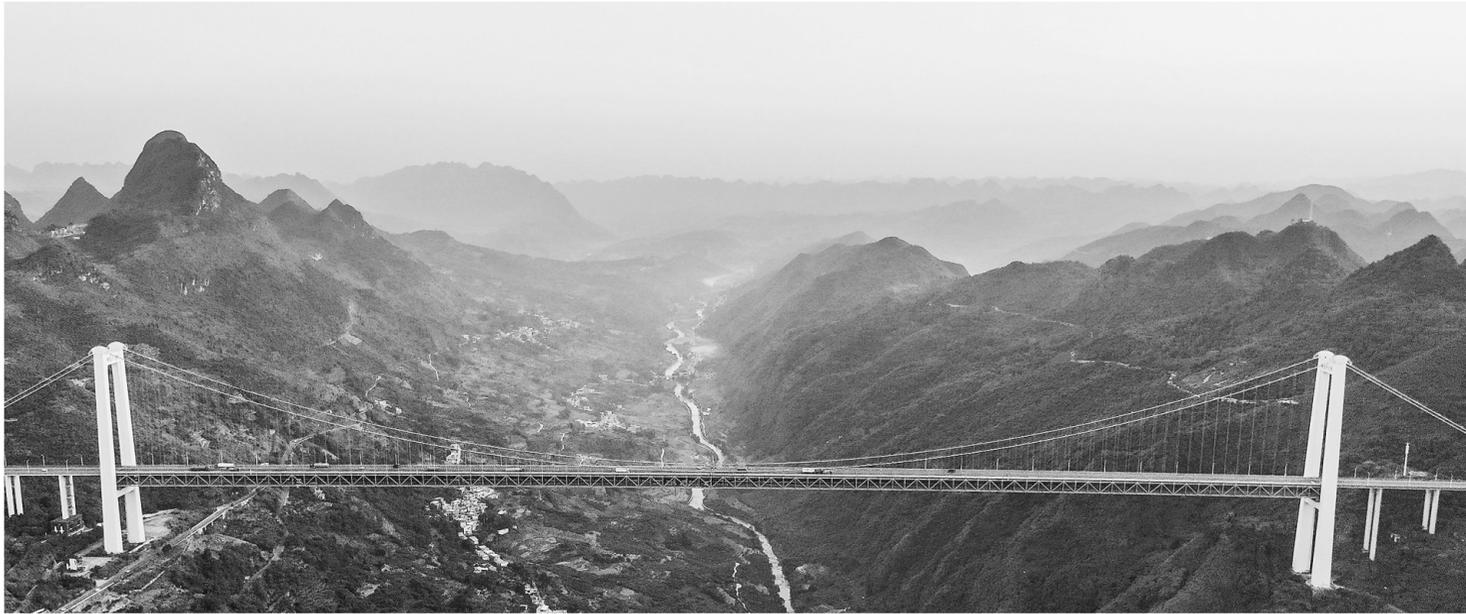
近日拍摄的贵州坝陵河大桥。位于贵州省安顺市境内的坝陵河大桥全长2237米,主跨1088米,距河面垂直高度370米,是上海至瑞丽高速公路贵州境内镇宁至云南胜境关高速公路上跨越坝陵河大峡谷的桥梁。
