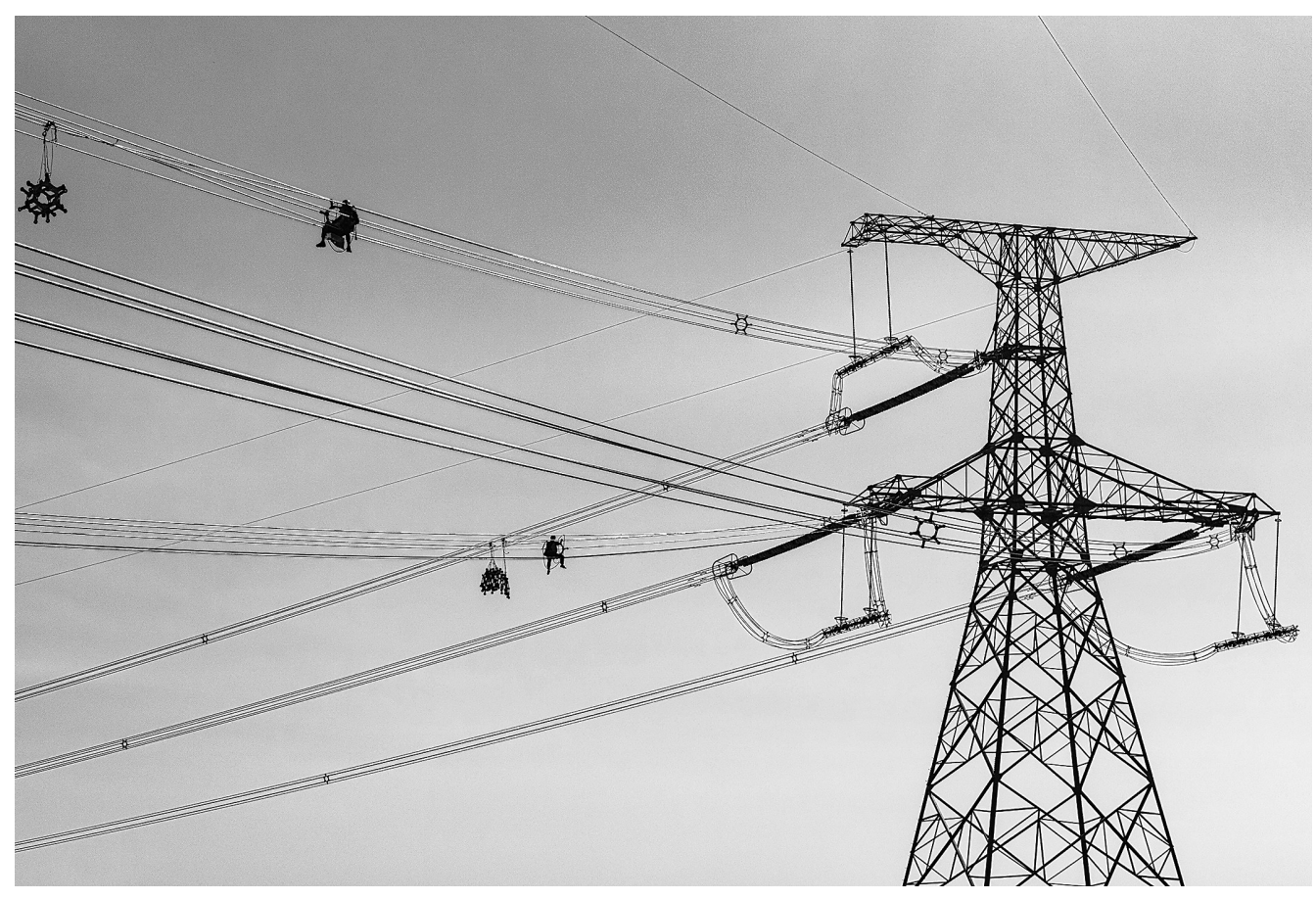
近日,位于宁县焦村段陡电入鲁工程750千伏庆阳换流站接入工程作业区,电力施工人员正在安装线路间隔棒,标志着该线路工程已进入收尾阶段。 新甘肃·甘肃日报通讯员 王启宁
