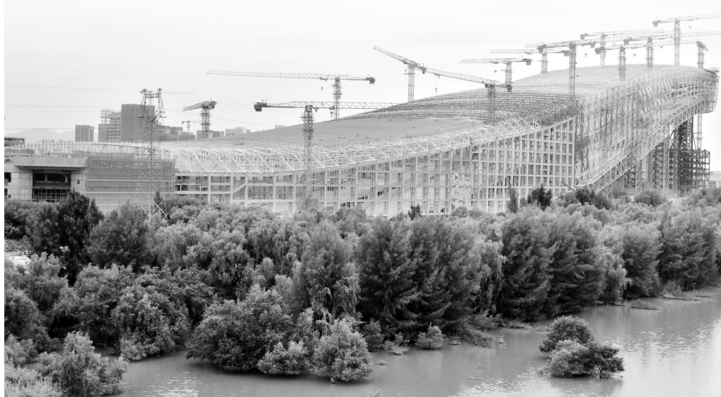
这是近日拍摄的深圳前海华发冰雪世界项目主体结构。由中建三局承建的深圳前海华发冰雪世界项目,目前主体结构全面封顶,已进入装饰装修阶段。(资料图) 新华社发
