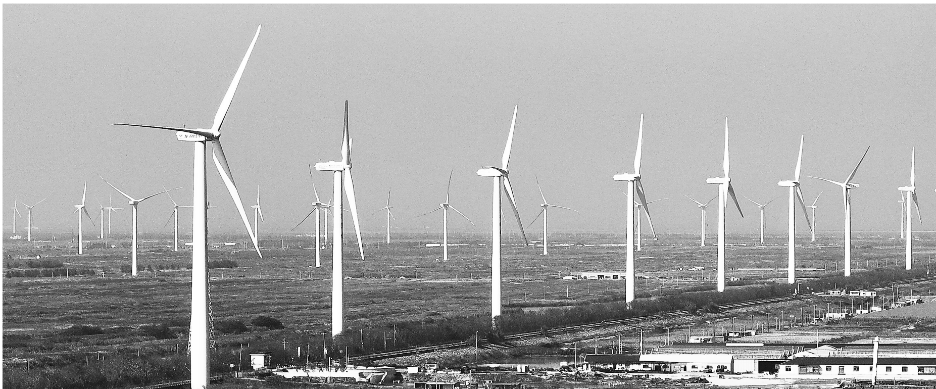
这是11月3日在江苏如东拍摄的风力发电机组(无人机照片)。近年来，江苏省南通市如东县以绿色低碳发展为导向，不断搭建完善风电、光伏全产业链，推动绿色产业集群加速集聚。
