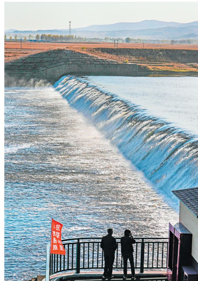
“引汤渠首”工程发挥着灌溉、发电、生态、旅游等综合效益,是造福汤原百姓的民生工程。
