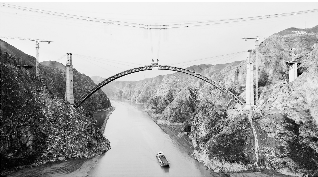
11月2日,兰合铁路洮河大桥主拱拱性骨架顺利合龙。
