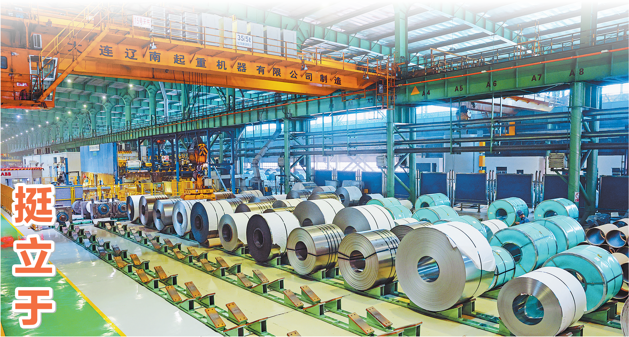
酒钢集团不锈钢分公司生产线。 新甘肃·甘肃日报记者 田蹊
