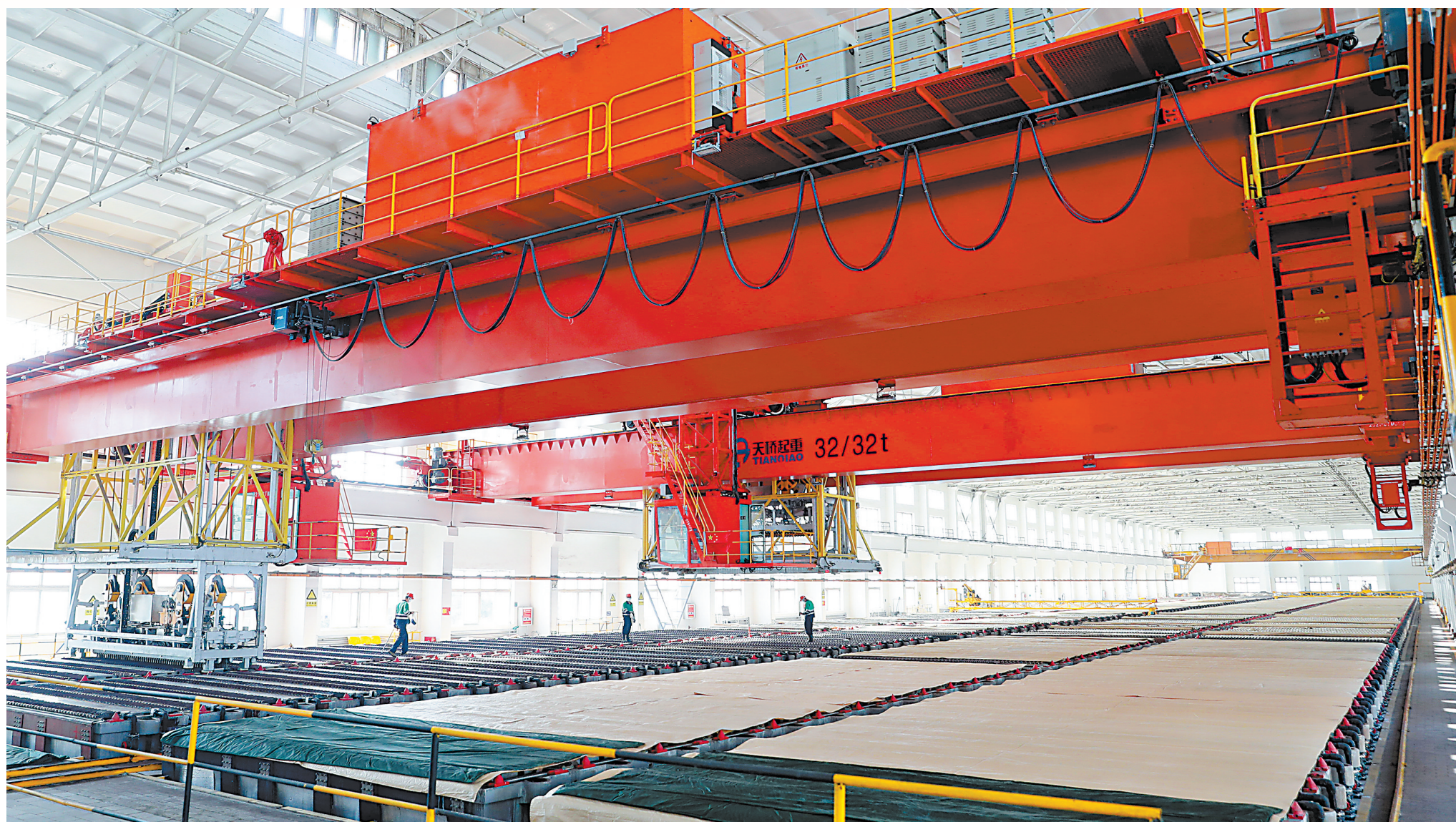
金川集团铜业有限公司铜电解Ⅱ系统工艺装备升级改造项目。 新甘肃·甘肃日报通讯员 张俊成
