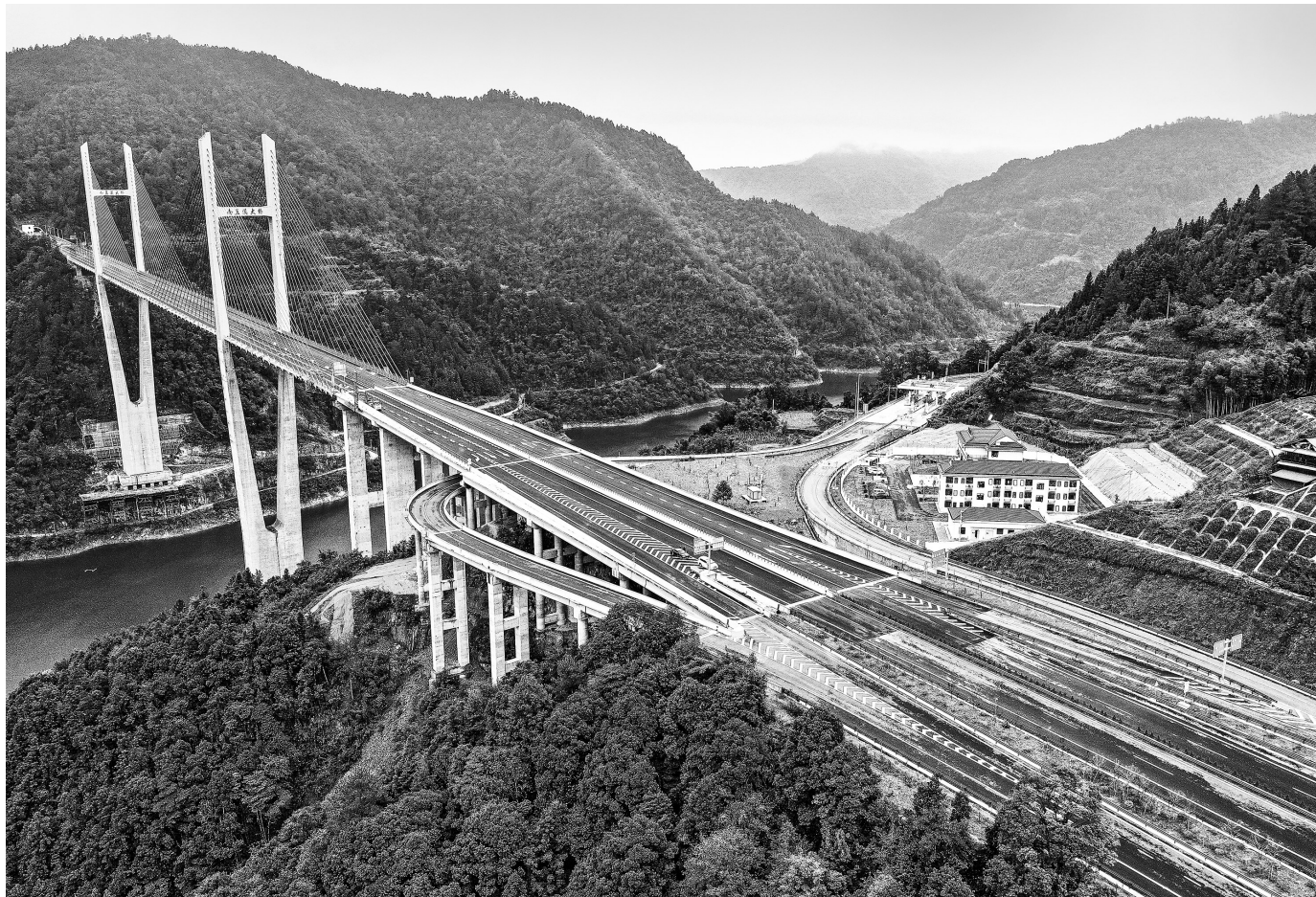
这是10月20日拍摄的贵州剑黎高速南孟溪大桥和南加互通。目前,剑河至黎平高速公路各项建设已接近尾声,剑黎高速公路建成通车后,对构建黔东南黄金旅游通道,加快沿线资源综合开发,助力乡村振兴具有重要意义。(新华社发)
