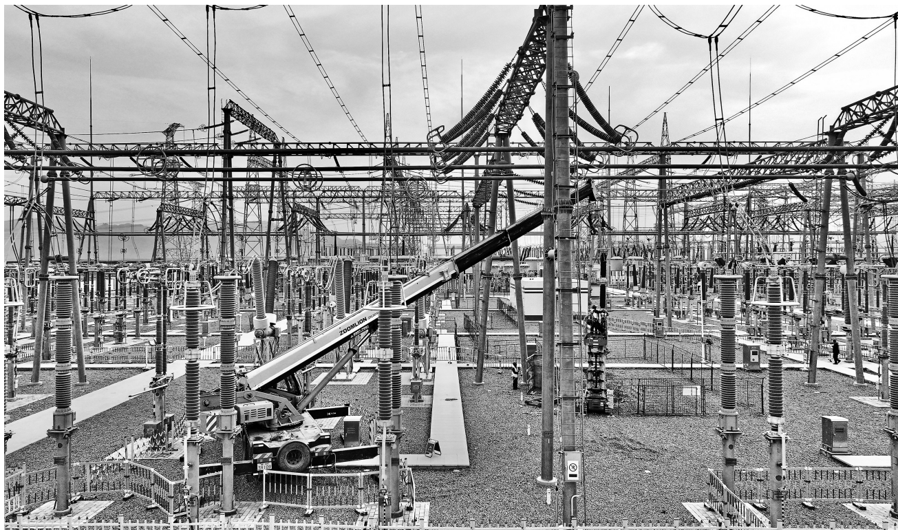
10月19日,国网甘肃超高压公司750千伏西变电站330千伏Ⅱ母线改造圆满结束。新甘肃·甘肃日报通讯员 苏容
