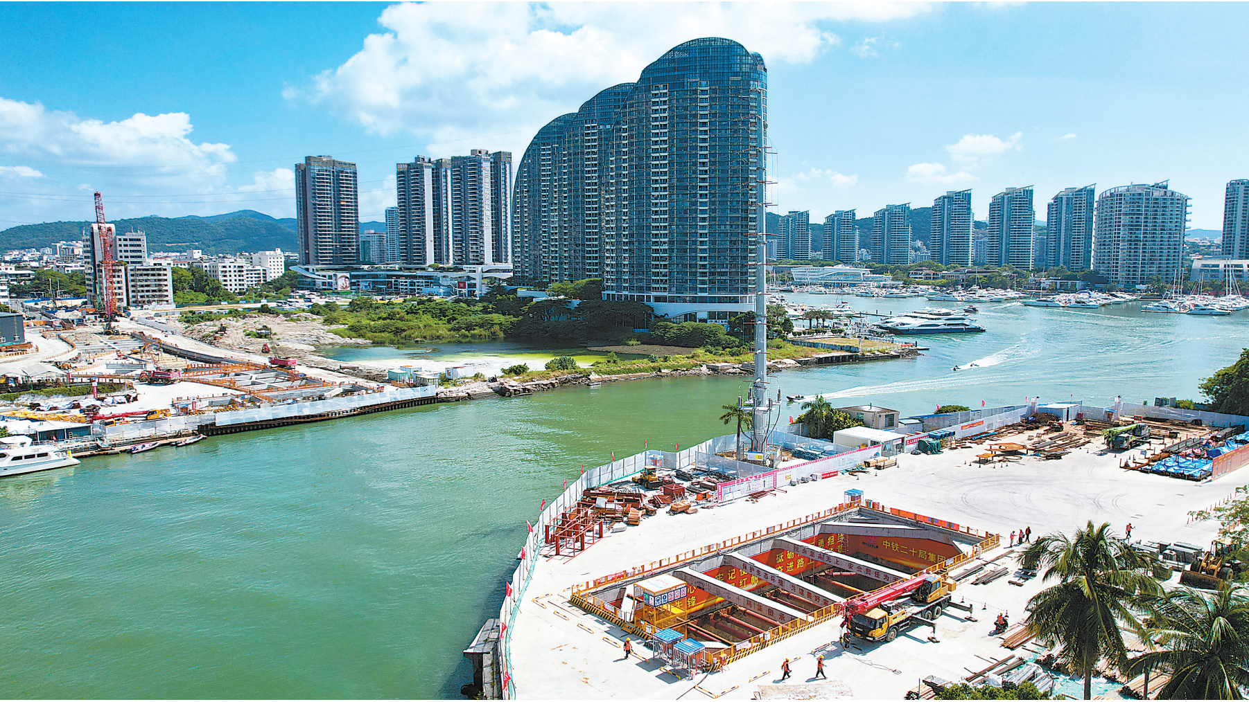
这是10月12日拍摄的三亚河口通道工程项目现场(无人机照片)。位于海南省三亚市天涯区的三亚河口通道工程项目目前建设稳步推进。该项目由中铁二十局承建,采用国内外首创三圆咬合顶管施工工艺,通过管幕结构加冷冻法施工工法的全海底作业方式,确保大量游艇游船进出港不受施工影响,有效保护周边海洋生态。
