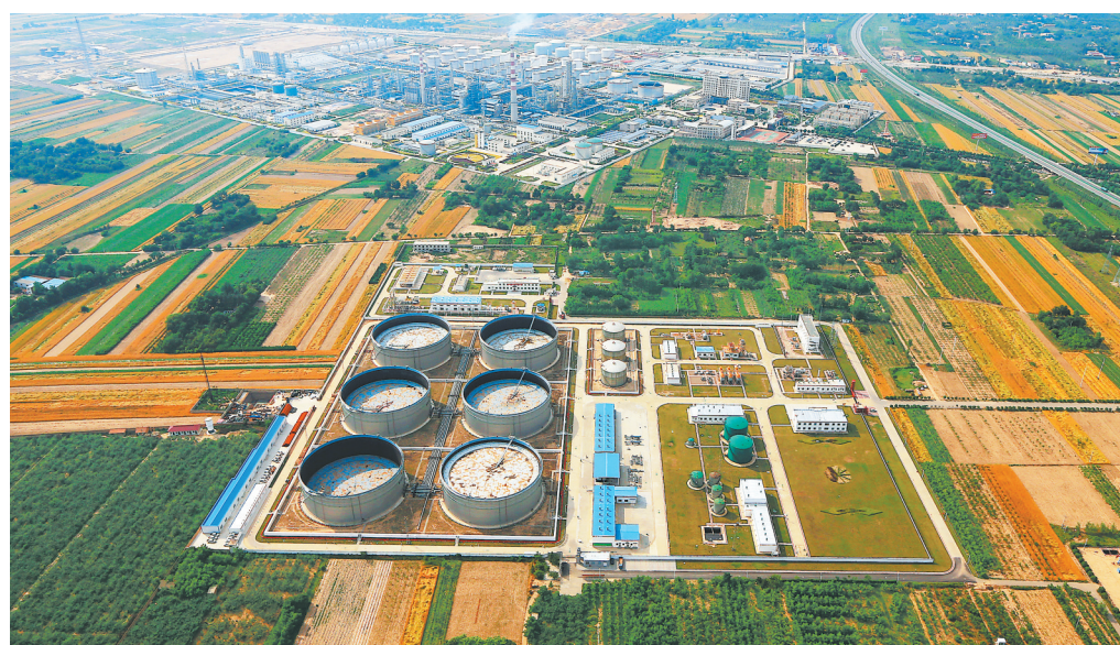
中国石化庆阳石化公司300万吨炼油搬迁改造项目。
