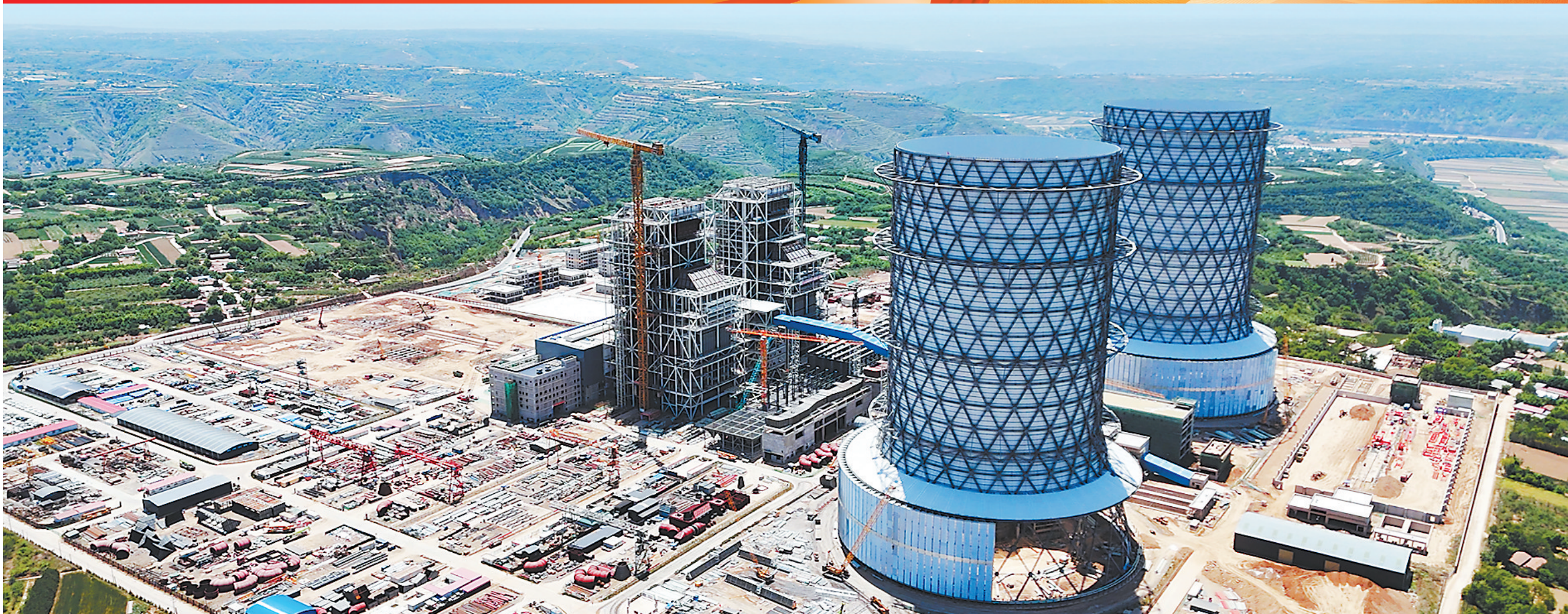
华能正宁电厂项目建设现场。
