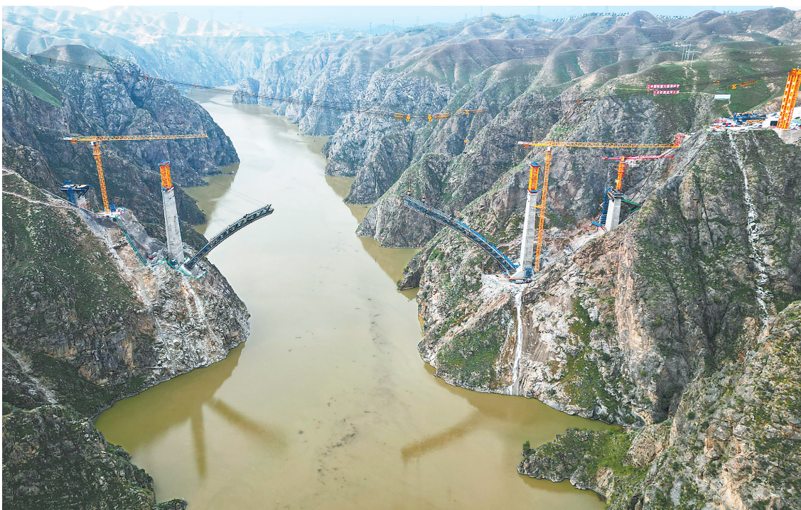
10月6日,西北地区跨度最大的铁路钢筋混凝土拱桥——兰合铁路洮河大桥开展动性骨架组拼及吊装施工。 新甘肃·甘肃日报通讯员 史有东
