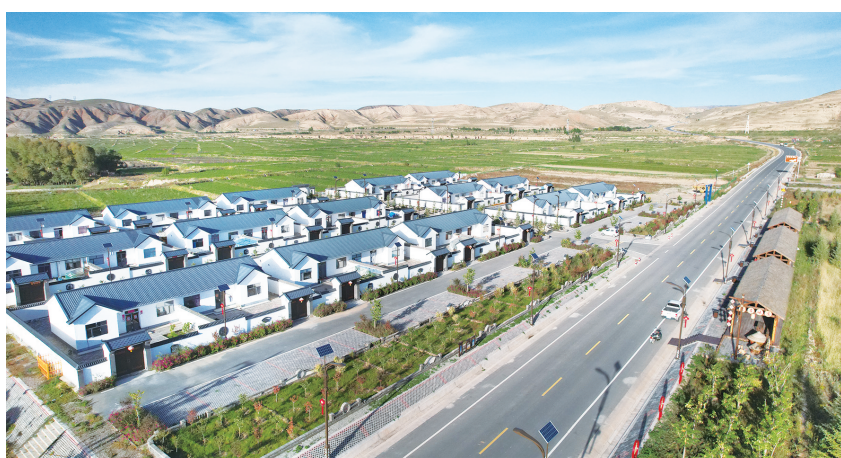
山丹县花寨村生态及地质灾害避险搬迁集中安置点。
