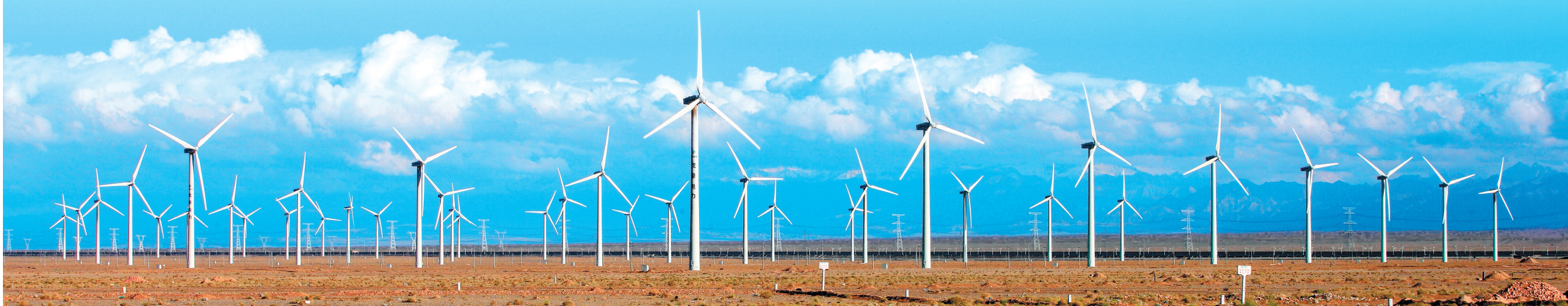
甘肃省抢抓“双碳”机遇,推动风、光、储一体发展,形成了“发输储用造”协同推进的新能源发展格局。
