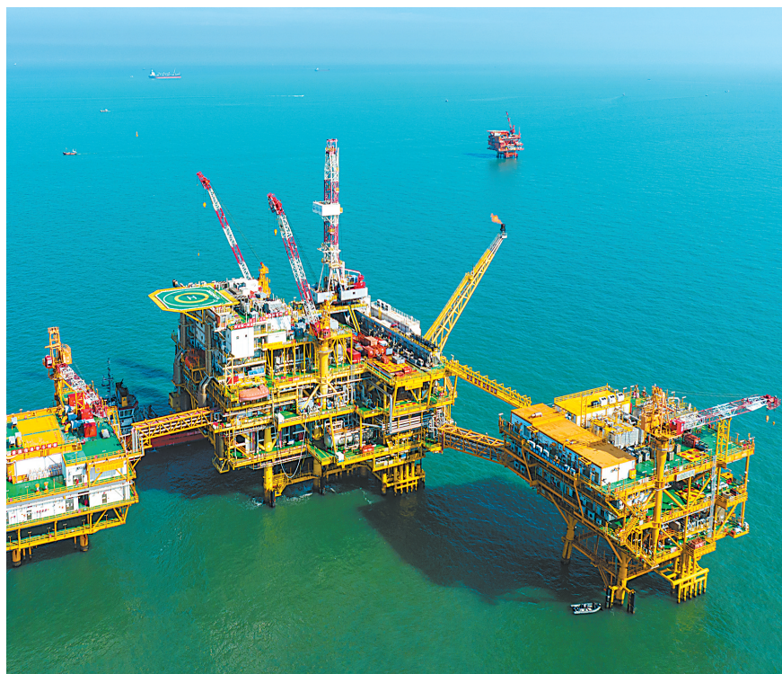
这是9月25日拍摄的连接了岸电的渤海油田海上作业平台。记者从中国海油天津分公司获悉,截至9月25日,渤海油田岸电应用项目累计供电超30亿千瓦时。岸电是将陆上网的电,通过海底高压电缆输送到海上油田,供油气开发生产使用。新华社发
