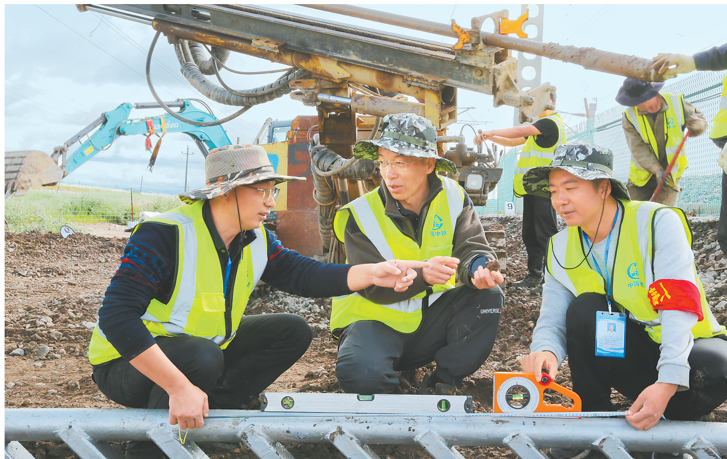
俞祁浩（前排左二）和团队成员查看施工场地。
