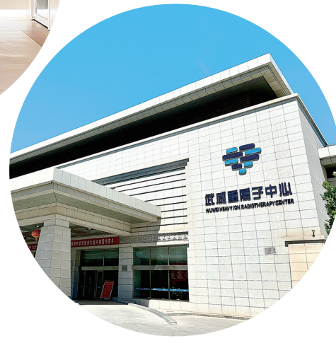
武威重离子中心主楼。
