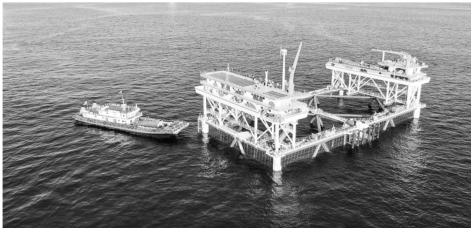
这是9月2日拍摄的中广核“伏羲一号”风渔融合网箱平台(无人机照片)。
