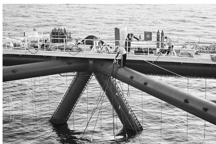
9月2日,工作人员在中广核“伏羲一号”风渔融合网箱平台调整投放装置。
