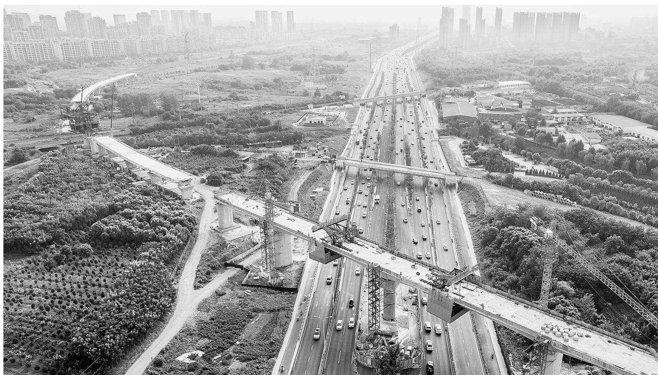
9月4日，合安铁路引入合肥枢纽跨包公大道特大桥合龙现场。合安铁路引入合肥枢纽工程是长三角交通网络中的重要组成部分，项目建成后，对于优化沿江地区铁路网布局、服务长江经济带协同发展，推动长三角高质量一体化发展等具有重要意义。新华社发
