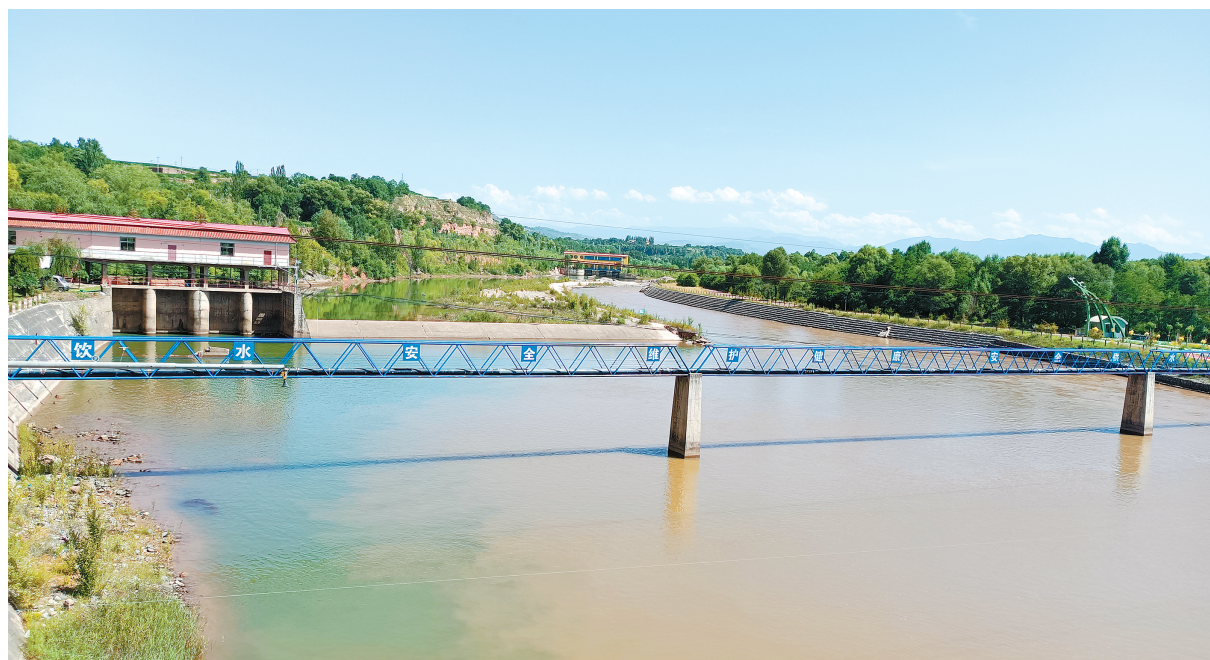
临洮县南部水厂跨洮河渡管。
