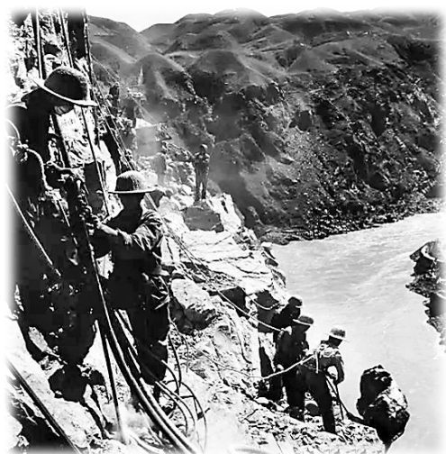
刘家峡水电站建设场景。
