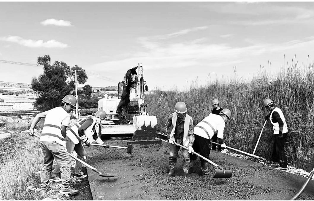
安定区团结镇小山村道路硬化现场,工人正在进行混凝土浇筑。近年来,团结镇大力实施道路硬化项目,改善了群众出行条件。新甘肃·甘肃日报通讯员 周雪晴
